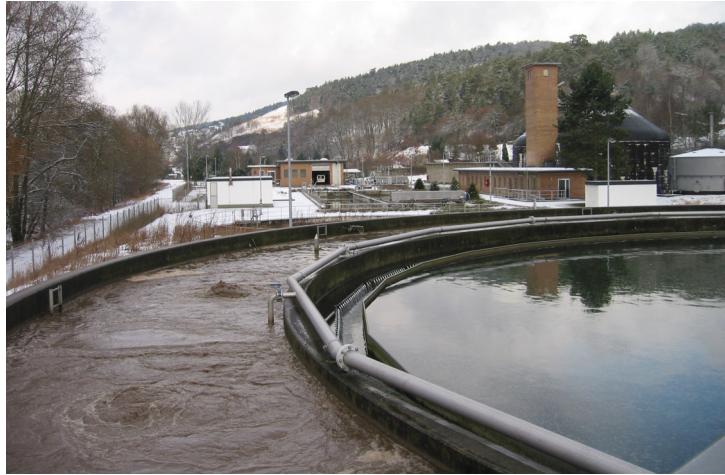
Gesamtansicht KA Dillenburg-Niederscheld
