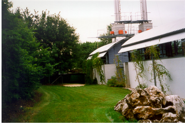
Rauchgasreinigungsgebäude mit Kamin
