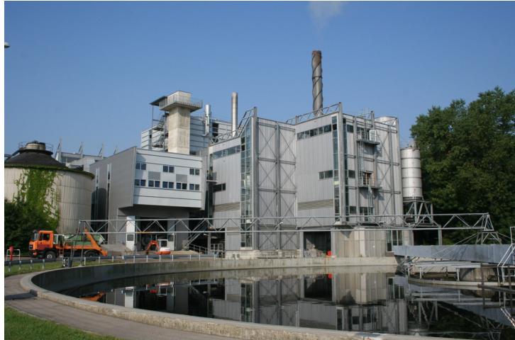
Gebäude der thermischen Schlammbehandlung
